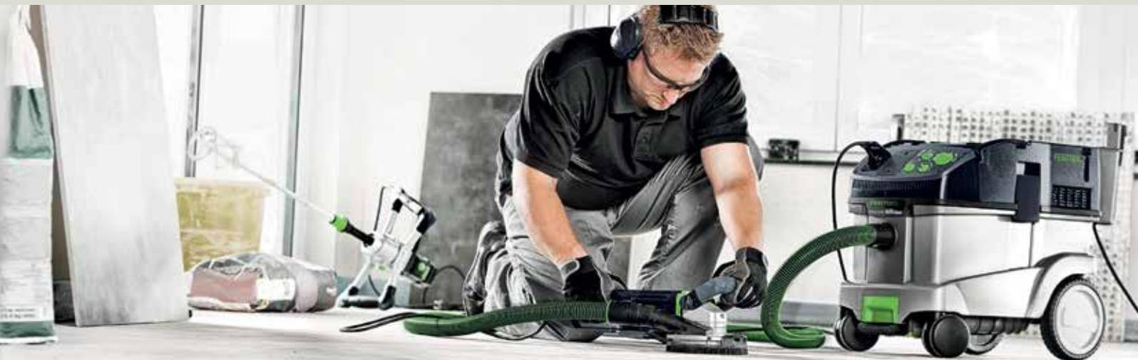
**Schnell und staubarm vorankommen:** Diamant Schleifsystem und Absaugmobil CTM 36 E AC HD für den schnellen und staubarmen Abtrag von Boden, Estrich und Beschichtungen.
