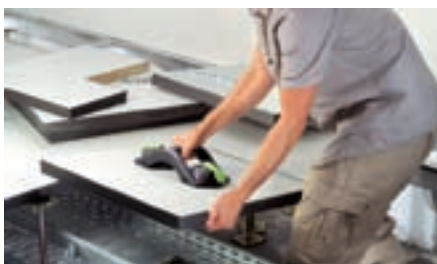
Ved udlægning af dobbeltgulv og laminatgulv er vakuumløfteren en stor hjælp.
